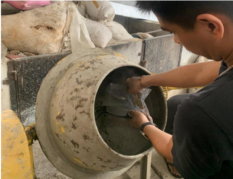
Gambar L.5: Proses pembuatan beton
