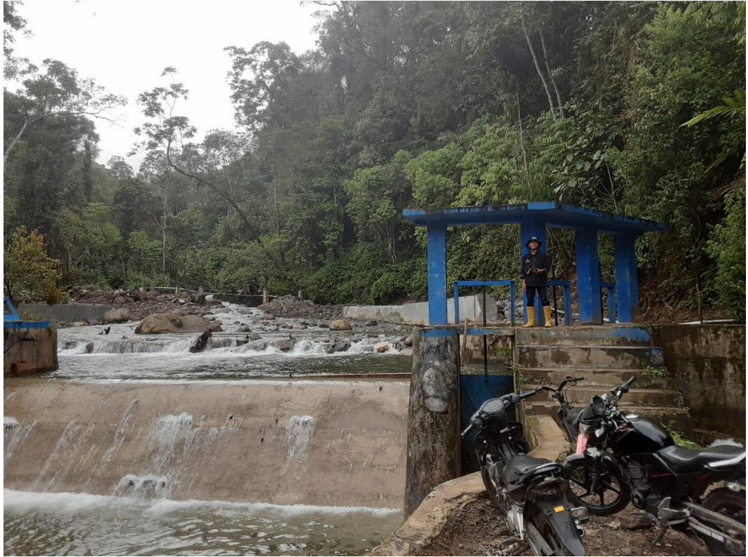
Gambar L.4 Surveyor mencatat kerusakan bangunan menggunakan aplikasi E-Paksi
