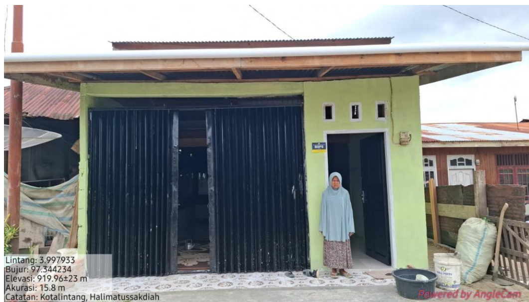
Gambar 4.5 Rumah ke 2 Sesudah Direnovasi
