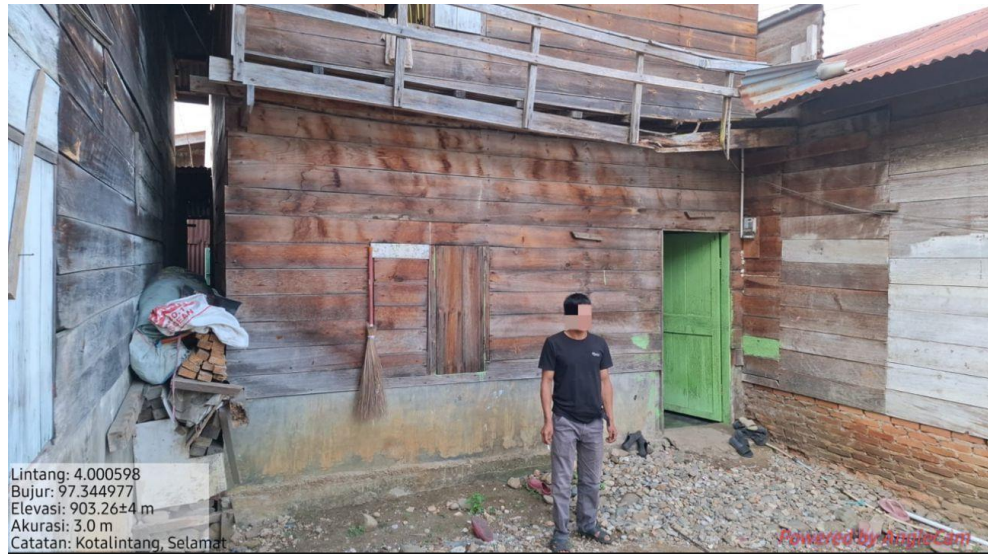
Gambar 4.2 Rumah Pertama Sebelum Direnovasi
