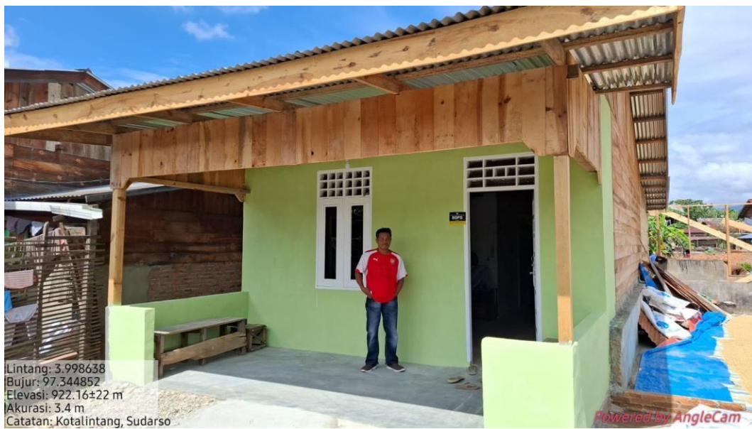
Gambar 4.7 Rumah ke 3 Sesudah Direnovasi
