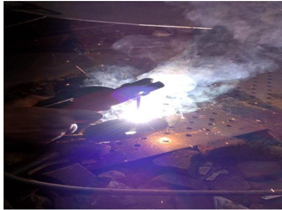
Gambar 4.3.6 Pengelasan atau penyambungan bagian atas tabung
