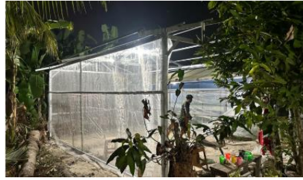
Gambar 4.3 Pemasangan Insect Net
