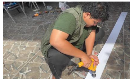
Gambar 4.5 Pembuatan lubang pada talang
