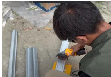
Gambar 4.1 Proses Perakitan Struktur Greenhouse
