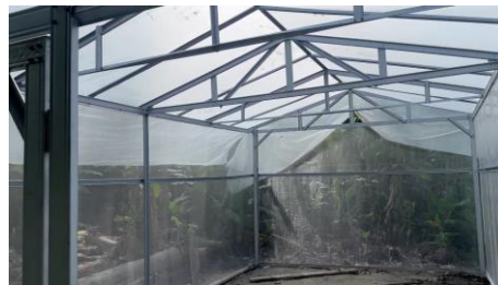
Gambar 4.2 Pemasangan Plastik UV
