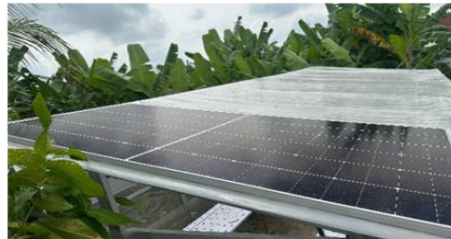
Gambar 4.7 Pemasangan Panel Surya pada atap greenhouse
