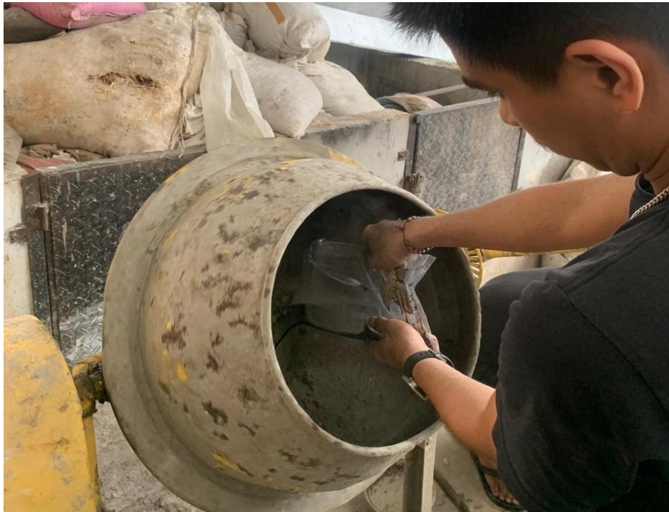
Gambar L.5: Proses pembuatan beton
