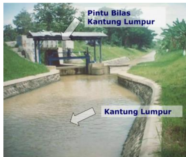
Gambar 2.2: Contoh kantong lumpur pada saluran irigasi (Google, 2025)
