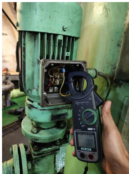
Gambar 4.2 Pengukuran Arus Pada Motor OWS Tidak Aktif
