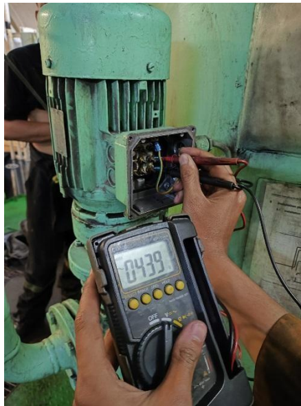
Gambar 4.3 Pengukuran Tegangan Pada Motor OWS Saat Aktif
