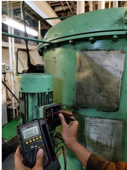
Gambar 4.1 Pengukuran Tegangan Pada Motor OWS Tidak Aktif
