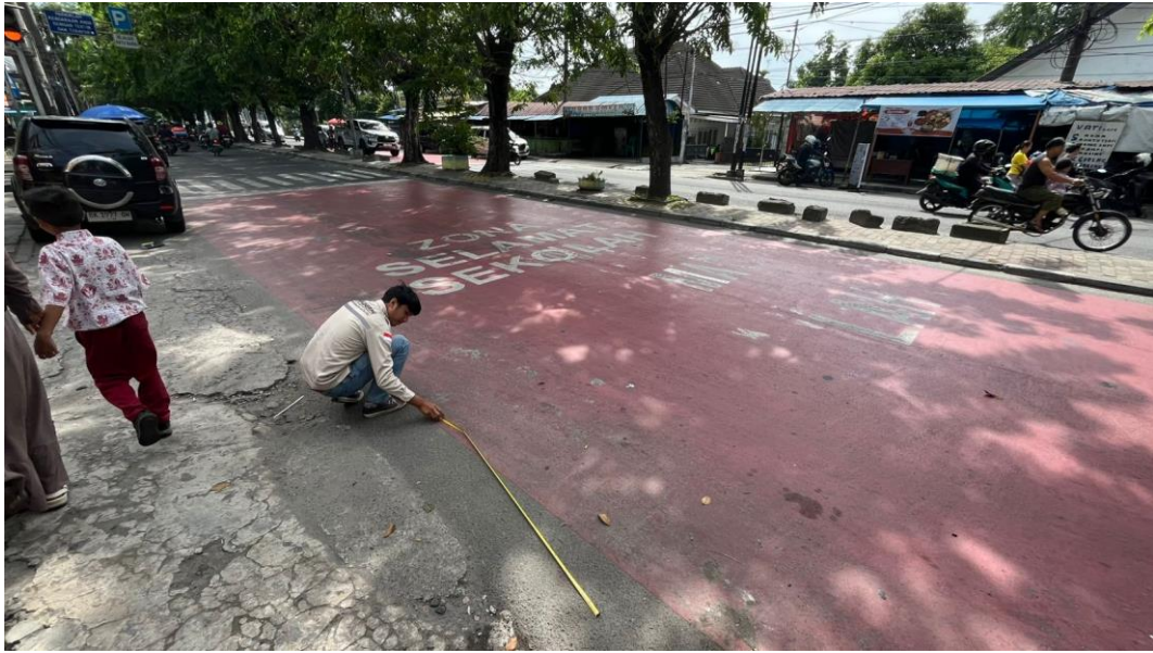
Gambar L.1: Pengukuran Geometrik Jalan.
