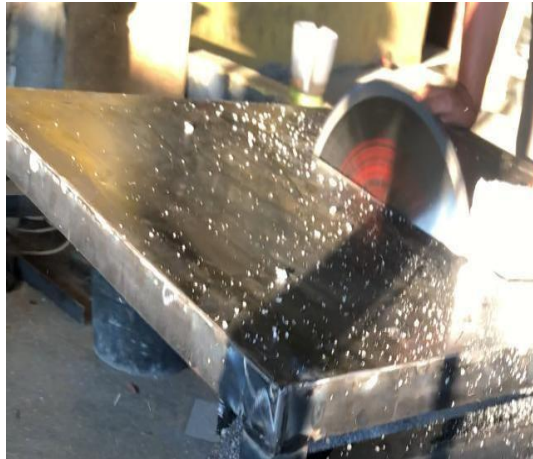
Gambar 4. 4 Hasil Pemasangan Plat Besi & Plat Stainless Pembuatan cover pelindung mesin
