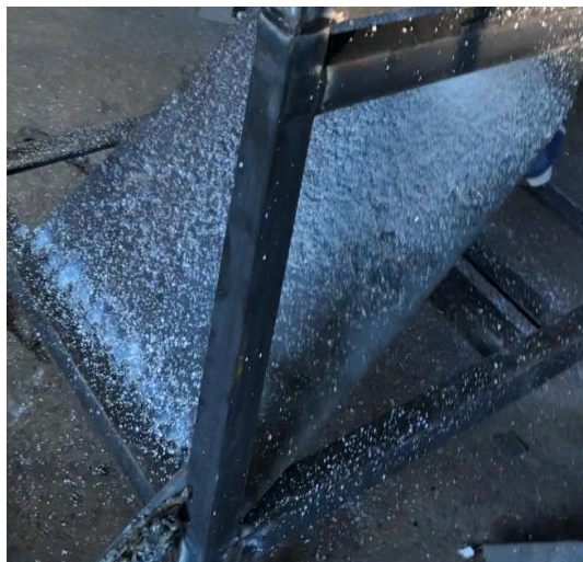
Gambar 4. 5. Hasil Pemasangan Plat Cover Pelindung Mesin
