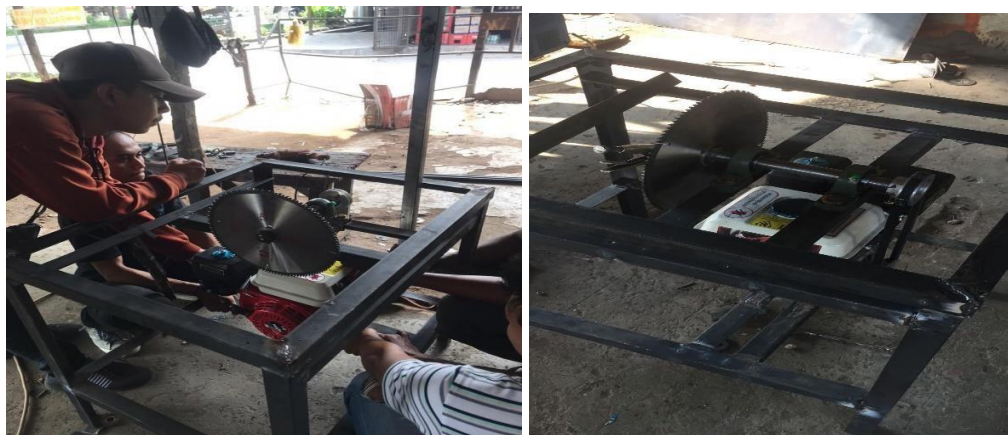
Gambar 4. 3 Pemasangan Mata Pisau dan Mesin
