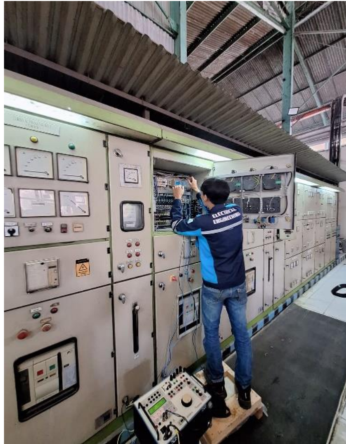
Gambar 4.8. Pengujian rangkaian sinkron pada panel turbine
