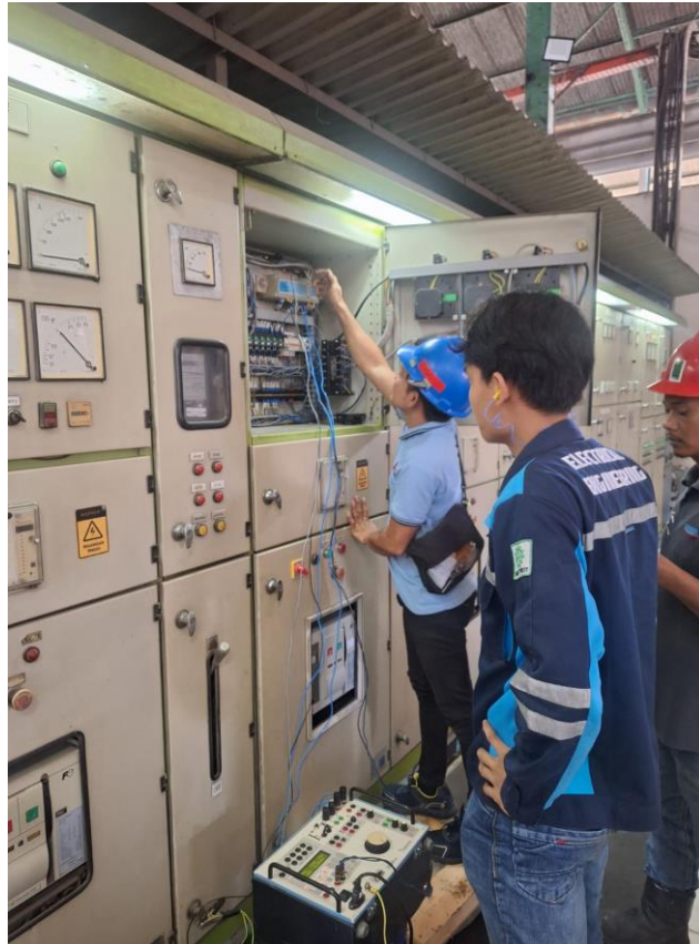
Gambar 4.10. Pergantian proteksi RPR yang mengalami kerusakan
