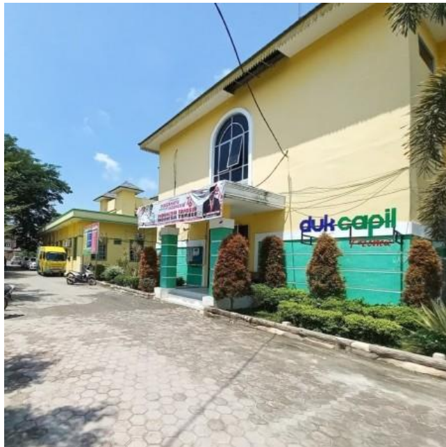
Gambar 3.2 Gedung Disdukcapil Serdang Bedagai
