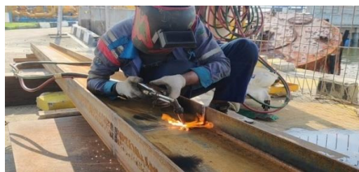
Gambar 4.6 Pemotongan Besi
