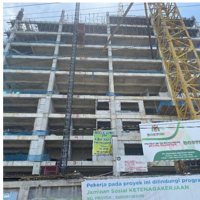
Gambar 3.3: Kondisi Lokasi Proyek
