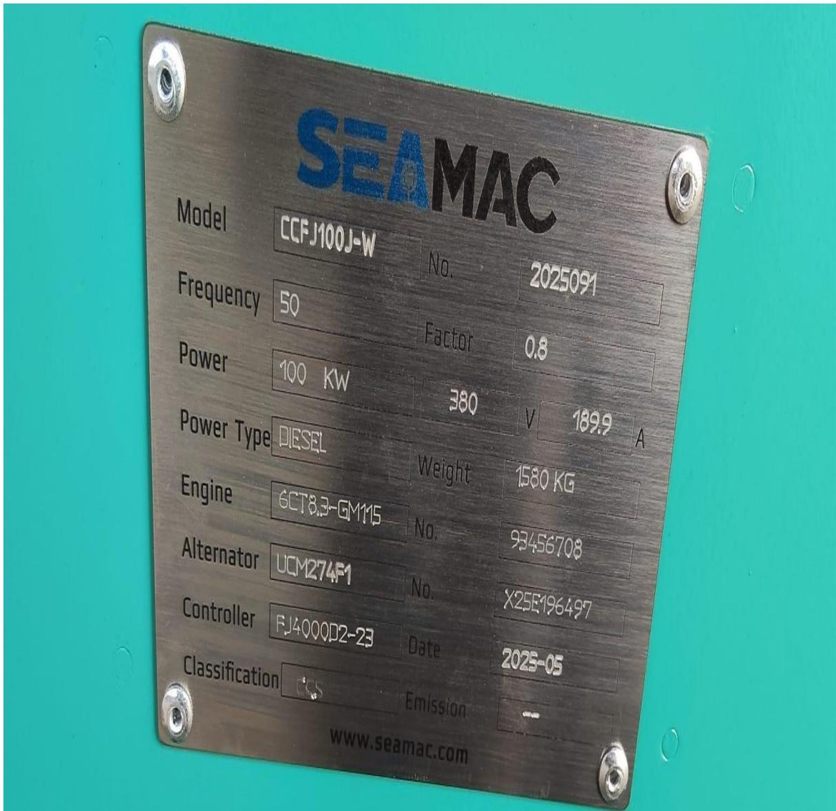
Gambar 1 Identifikasi nameplate Generator Set Kapal Tugboat
