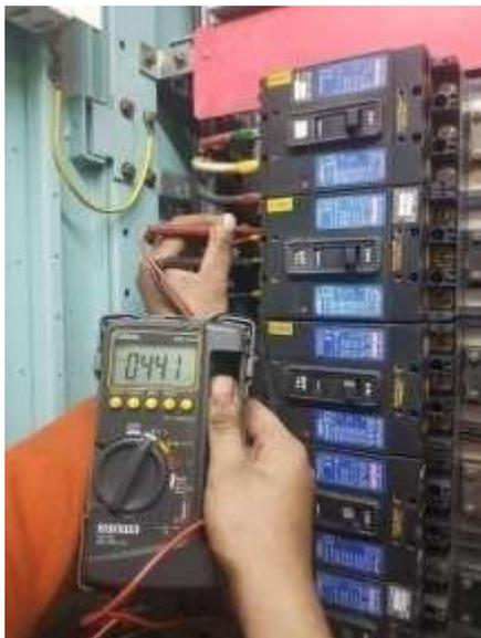
**Gambar 4. 2** Pengukuran Tegangan Pada Beban Feeder 440 VAC
