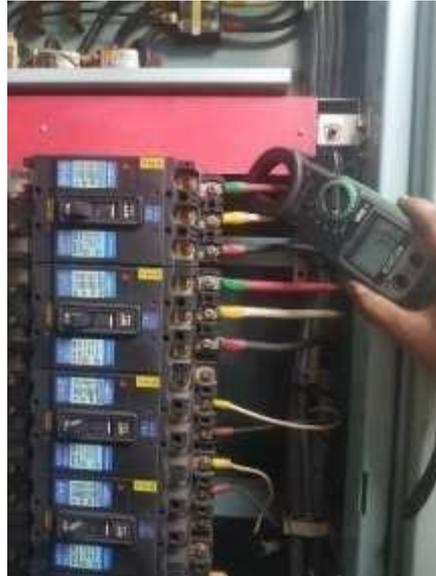
**Gambar 4. 7** Pengukuran Arus Pada Beban Feeder 220 VAC
