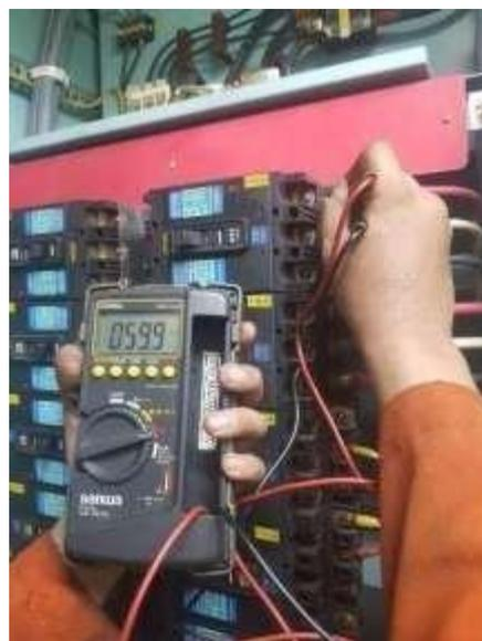
**Gambar 4. 6** Pengukuran Frekuensi Pada Beban *Feeder* 220 VAC
