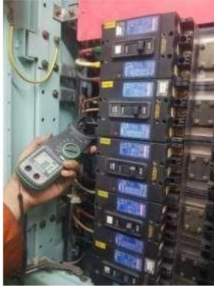
**Gambar 4. 4** Pengukuran Arus Pada Beban Feeder 440 VAC
