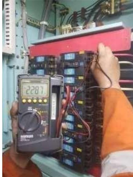
**Gambar 4. 5** Pengukuran Tegangan Pada Beban *Feeder* 220 VAC
