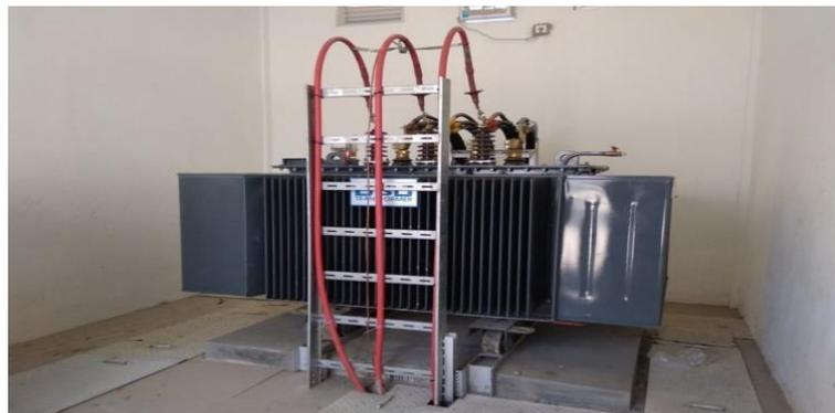
Gambar 2.8 Transformator Pemakaian Sendiri
