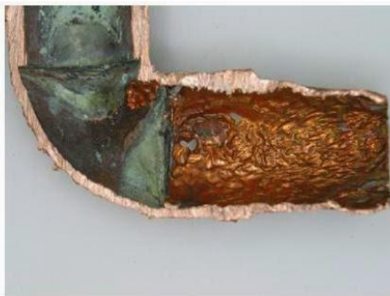
Gambar 2. 3 Korosi Erosi (Hasyim et al., 2017)
