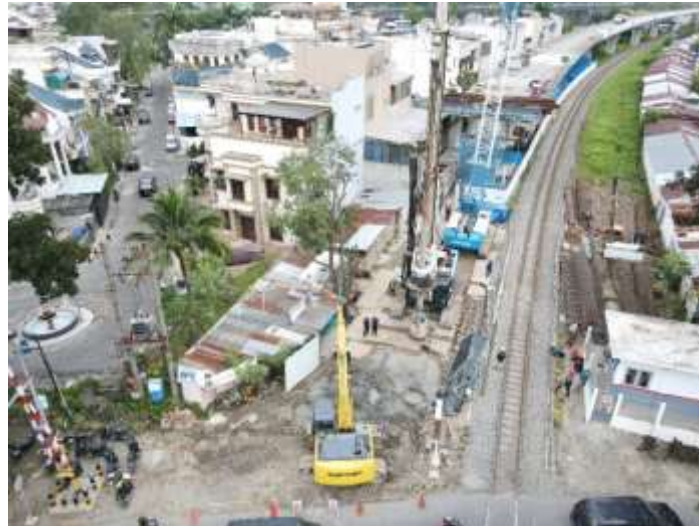
Gambar 2.1: Pekerjaan Proyek Pembangunan Jalur KA Medan – Binjai & Stasiun Medan
