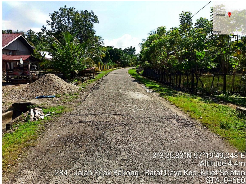
Gambar L.15: Kondisi jalan di STA 0+660.
