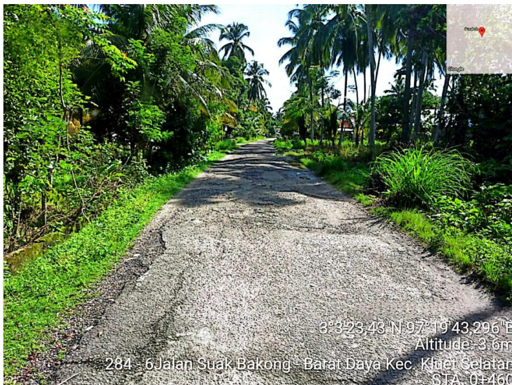
Gambar L.10: Kondisi jalan di STA 0+460.
