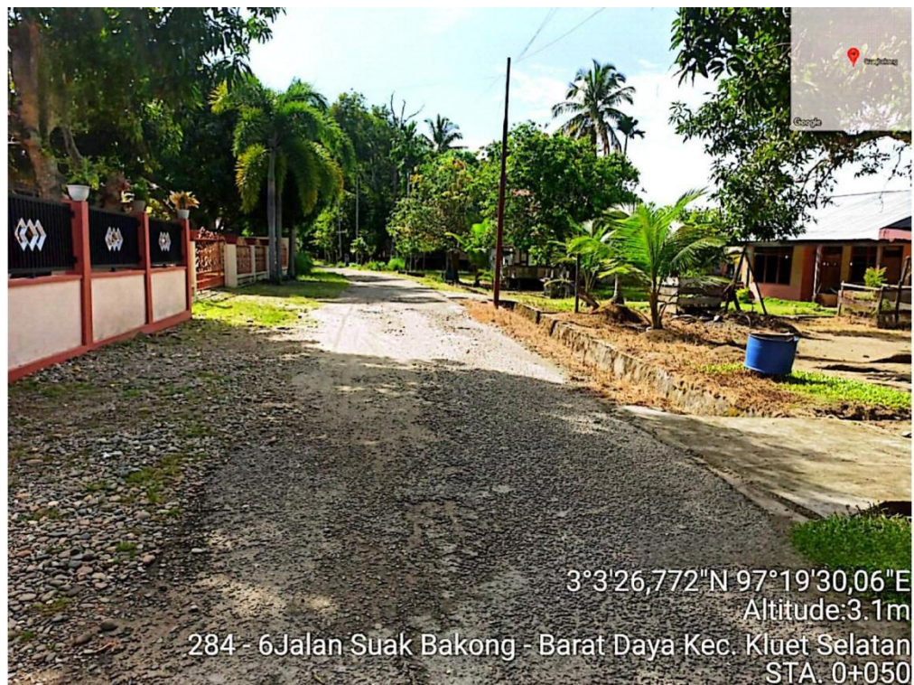
Gambar L.2: Kondisi jalan di STA 0+050.
