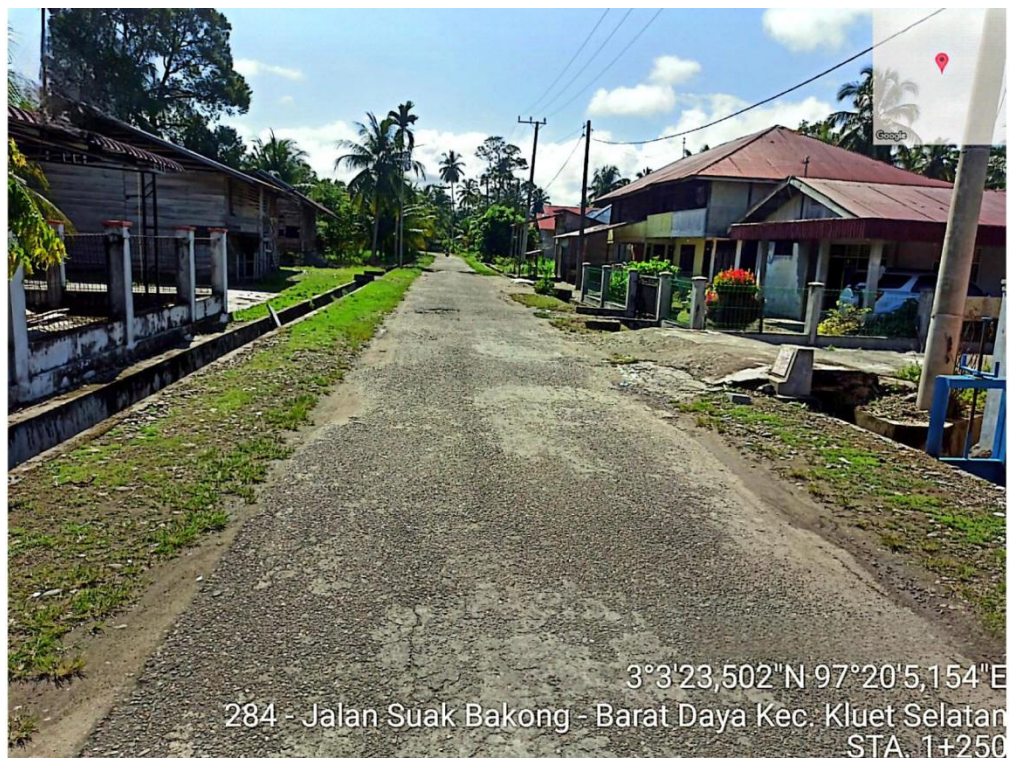
Gambar L.26: Kondisi jalan di STA 1+250.
