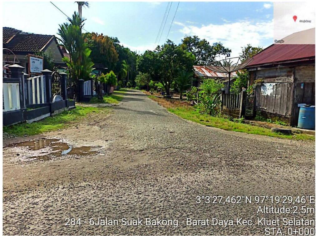
Gambar L.1: Kondisi jalan di STA 0+000.
