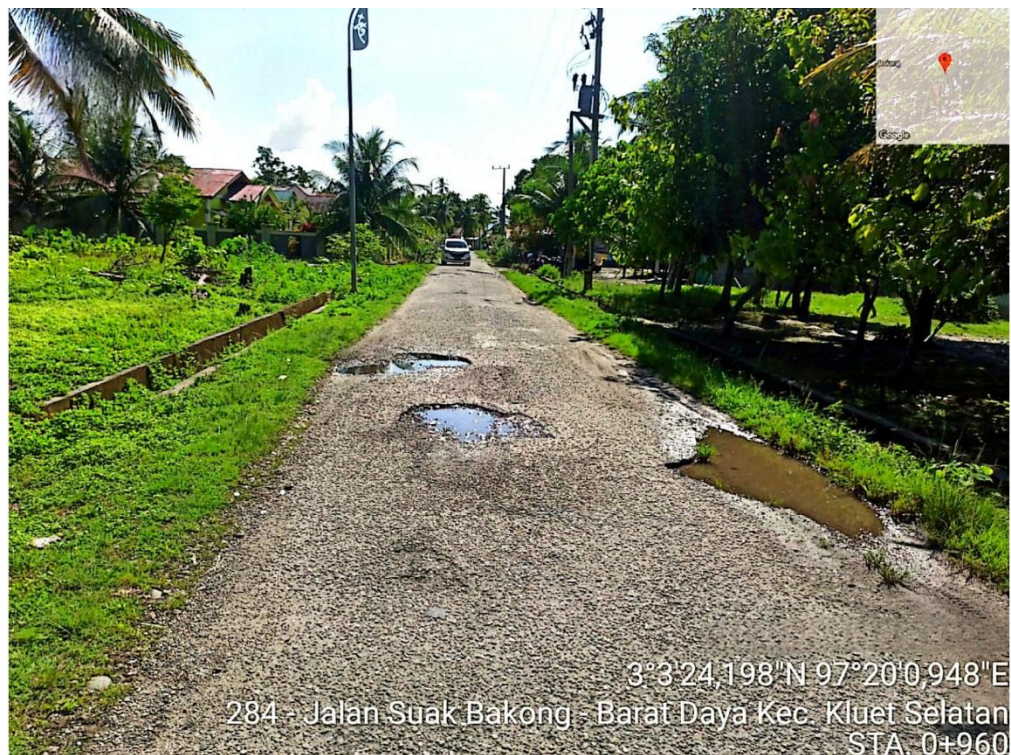
Gambar L.22: Kondisi jalan di STA 0+960.
