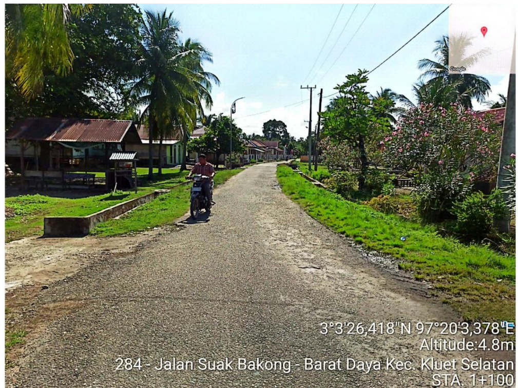
Gambar L.24: Kondisi jalan di STA 1+100.
