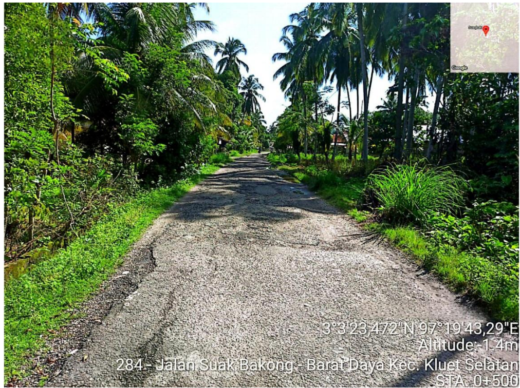
Gambar L.11: Kondisi jalan di STA 0+500.
