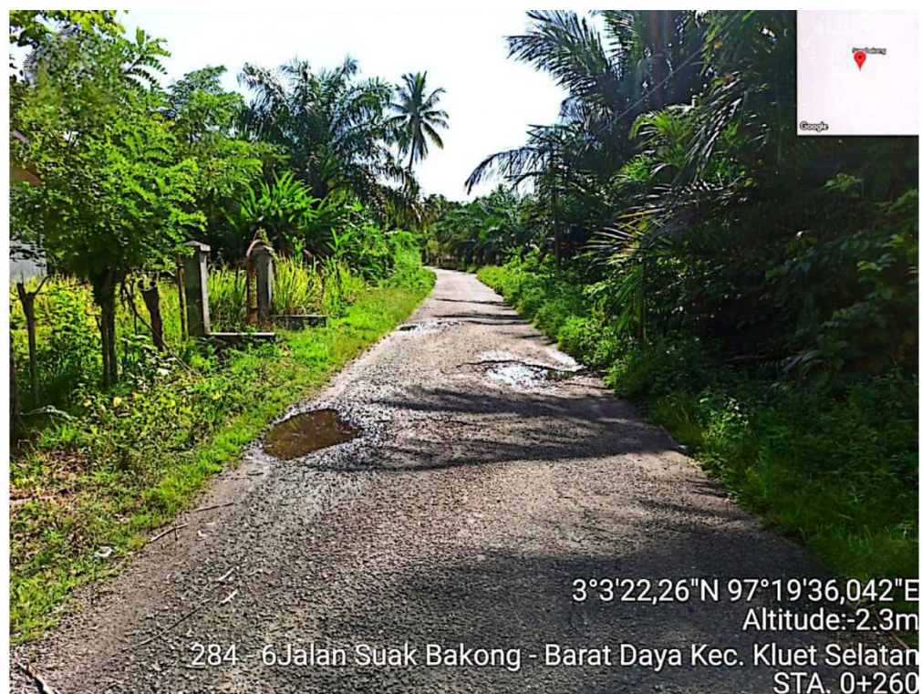
Gambar L.6: Kondisi jalan di STA 0+260.
