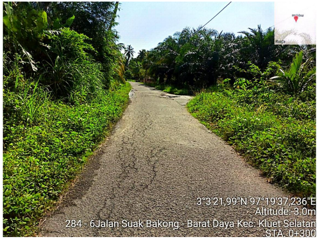
Gambar L.7: Kondisi jalan di STA 0+ 300.
