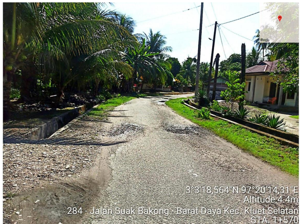
Gambar L.32: Kondisi jalan di STA 1+570.
