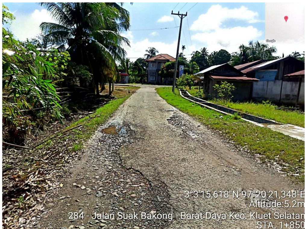
Gambar L.36: Kondisi jalan di STA 1+850.
