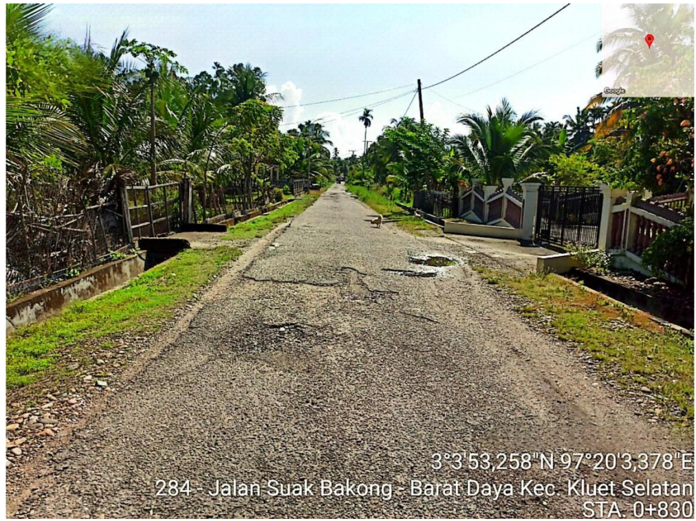
Gambar L.19: Kondisi jalan di STA 0+830.
