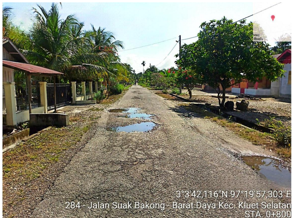
Gambar L.18: Kondisi jalan di STA 0+800.
