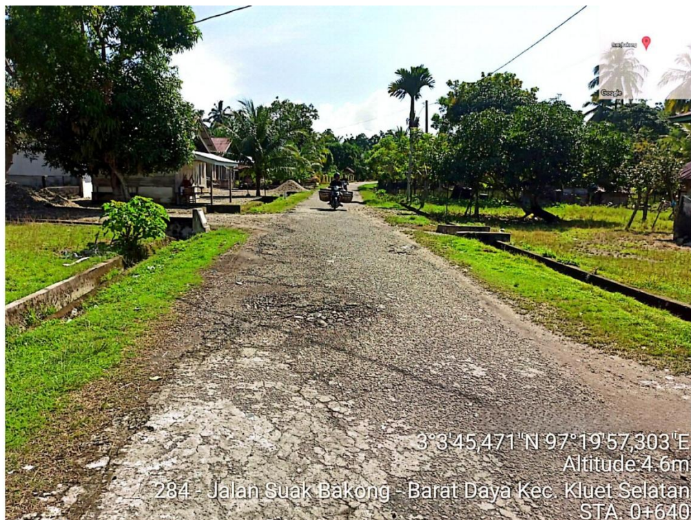
Gambar L.14: Kondisi jalan di STA 0+640.
