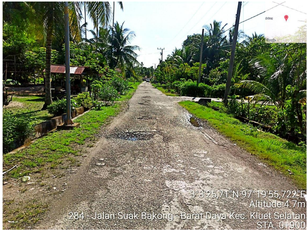
Gambar L.21: Kondisi jalan di STA 0+900.
