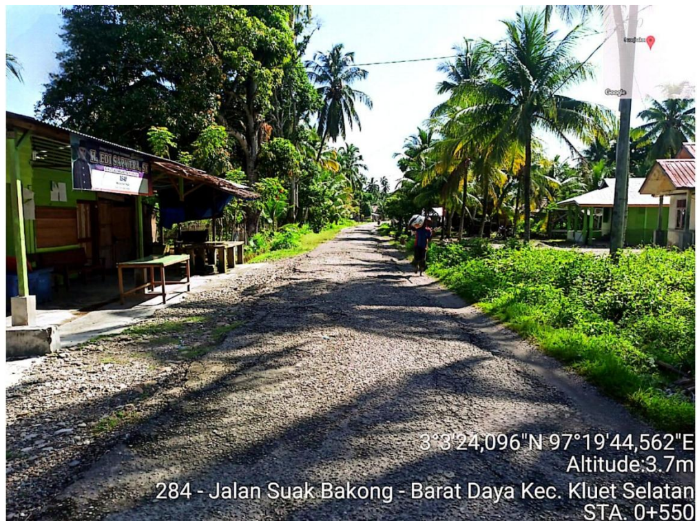
Gambar L.12: Kondisi jalan di STA 0+550.
