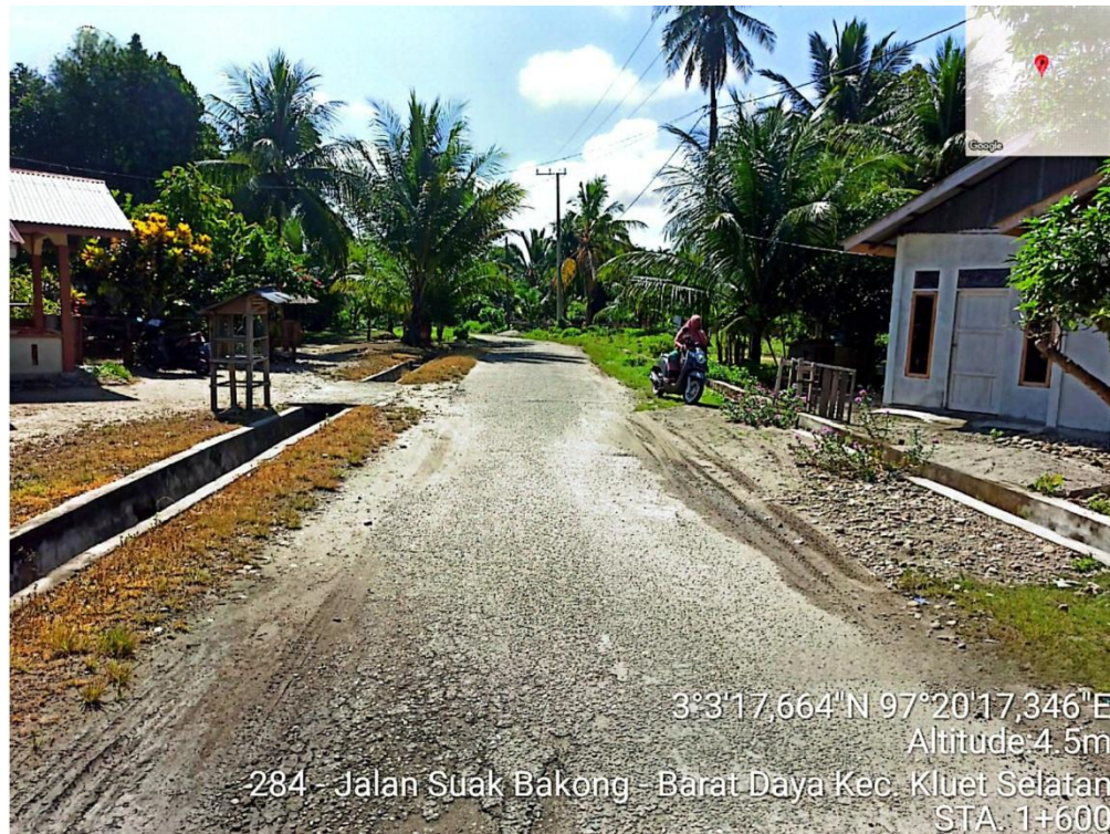
Gambar L.33: Kondisi jalan di STA 1+600.
