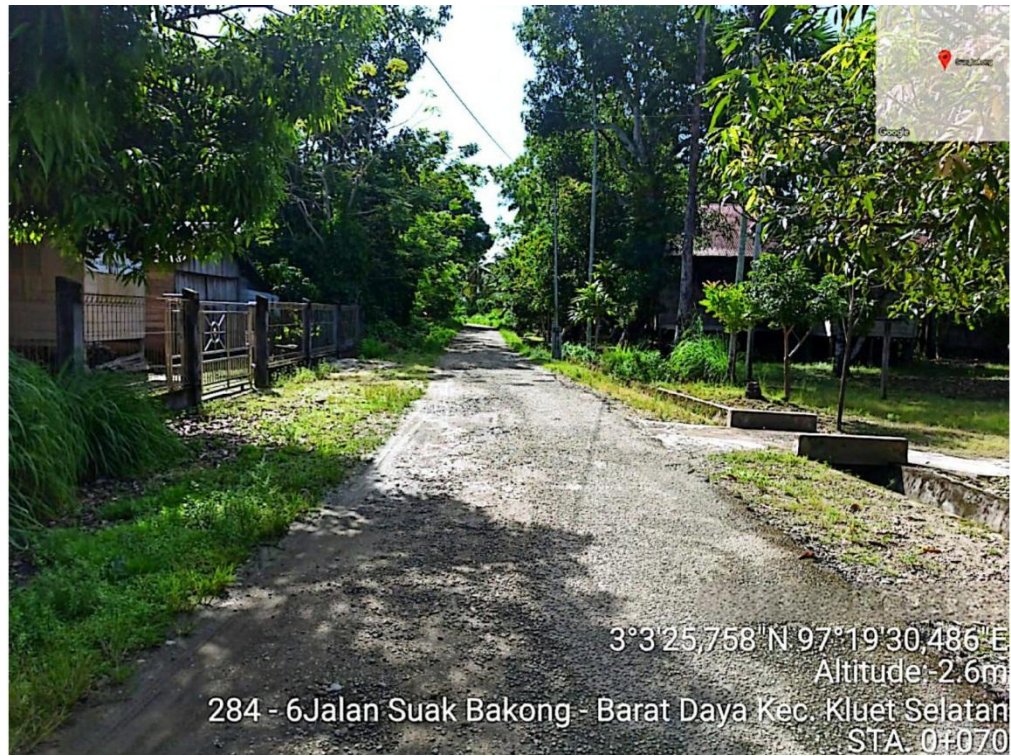
Gambar L.3: Kondisi jalan di STA 0+070.
