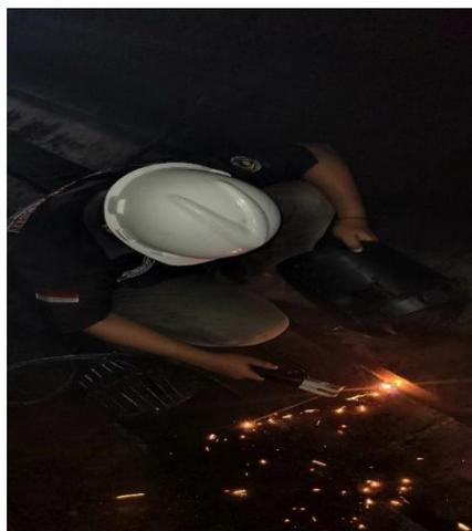
Melakukan *preventive maintenance* pada rail track sterilizer yang terlepas dari liner rebusan
