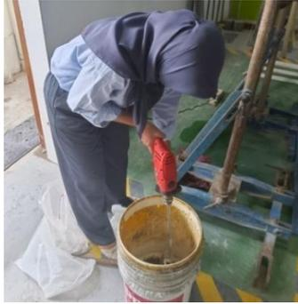
Gambar 3.85: Mengaduk semua bahan menggunakan mesin bor.
