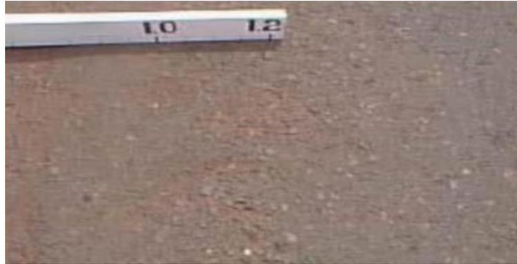
Gambar 2.16: Pengausan agregat (Lestari, 2020)
