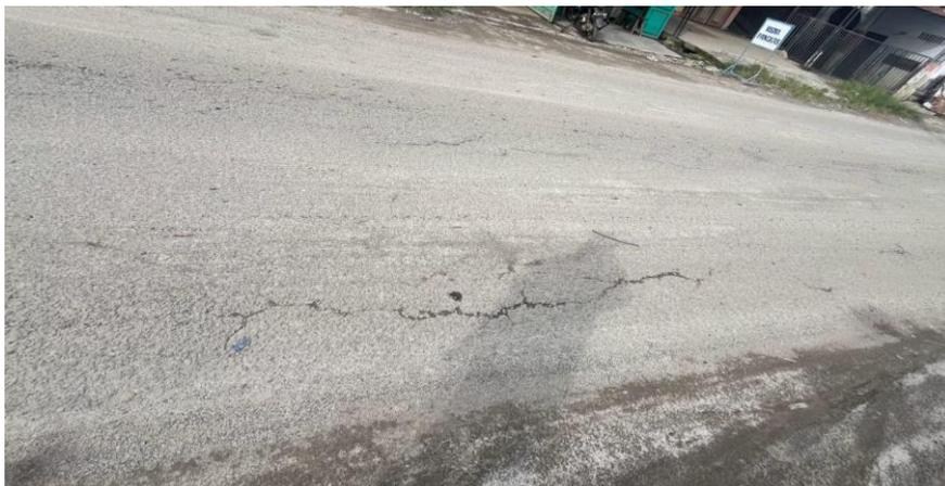
Gambar 3.7 Retak Memanjang (Hasil Survey dilapangan)
