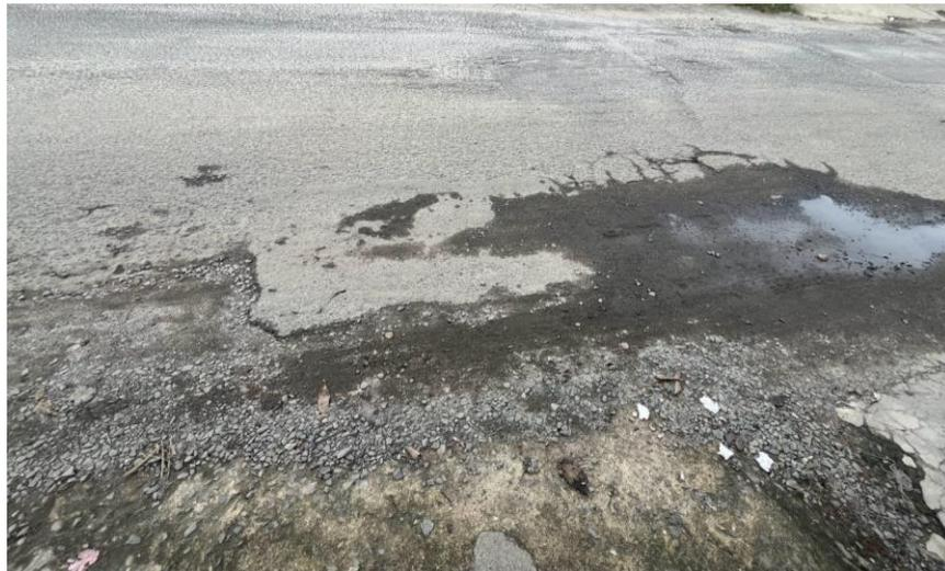
Gambar 3.10 Pelepasan agregat (Hasil Survey dilapangan)
