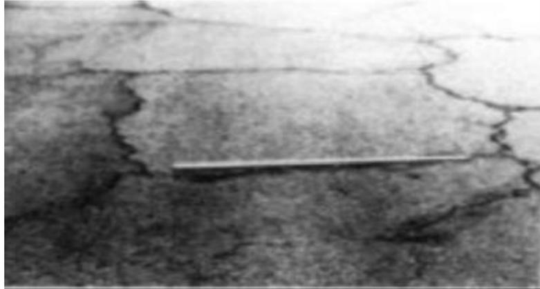
Gambar 2.7: Retak kotak-kotak (Lestari, 2020)
