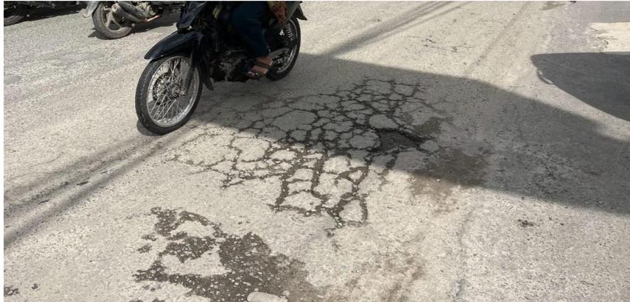
Gambar 3.3 Retak Kulit Buaya (Hasil Survey dilapangan)
