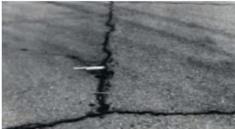
Gambar 2.12: Retak sambung (Lestari, 2020)
