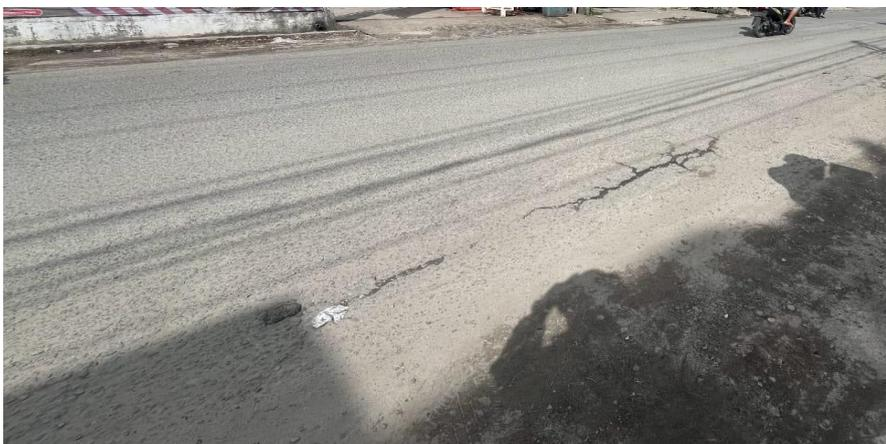
Gambar 3.5 Retak Pinggir (Hasil Survey dilapangan)
