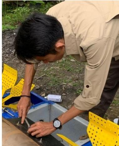
Gambar 4.18 Memasang Baut Dan Mengunci *Scraper* Karet
