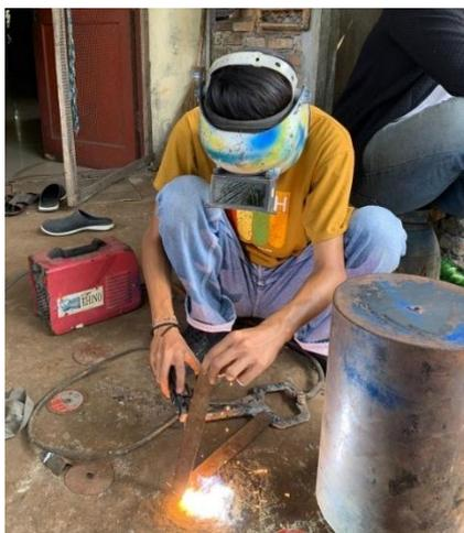
Gambar 4.14 Proses Pengelasan Pada Plat *Strip*
