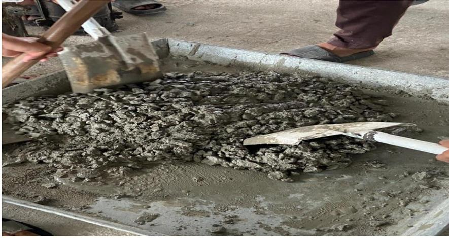
Gambar L-1 Pembuatan Campuran Beton
