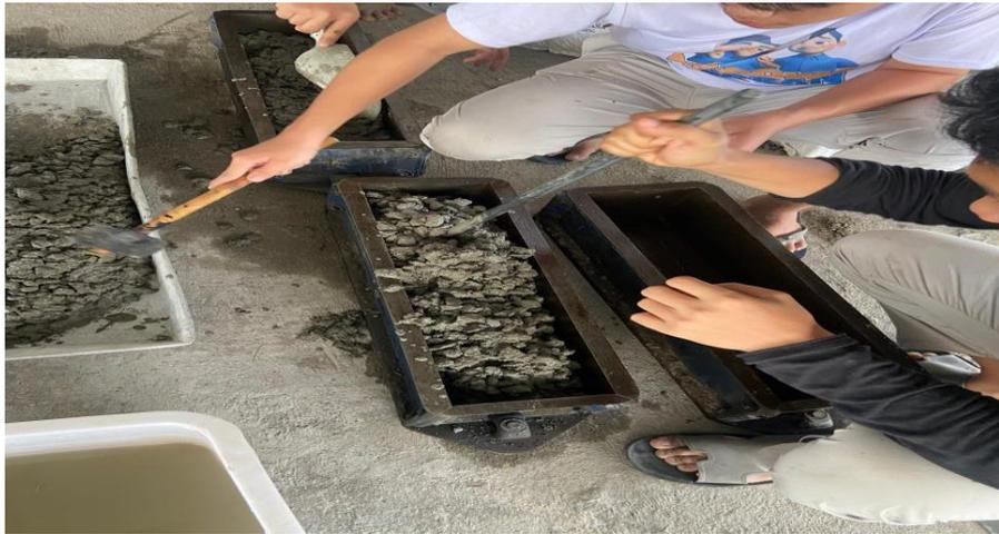
Gambar L-2 Pencetakan Beton Balok
