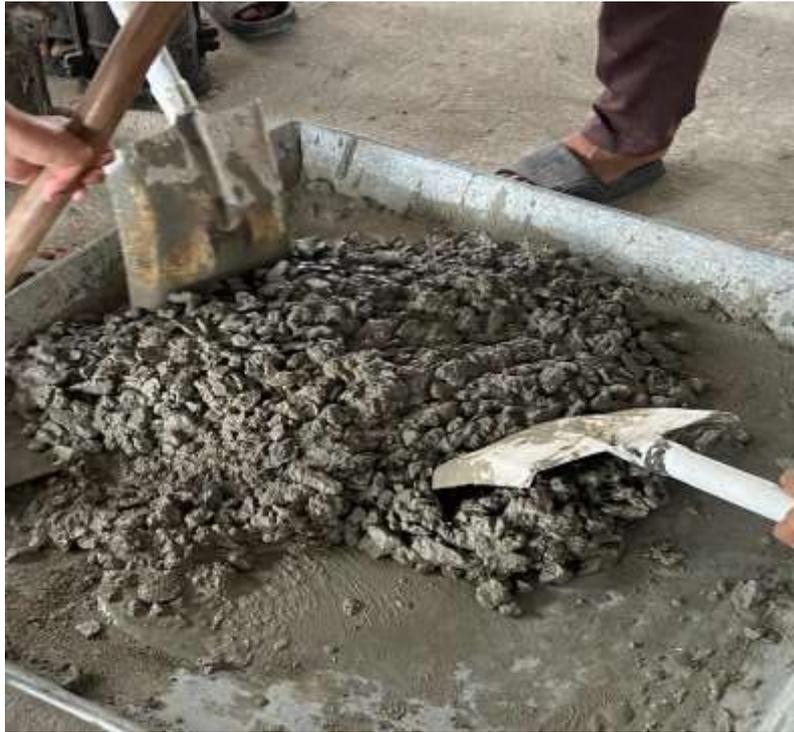
Gambar L.5: Proses pembuatan beton secara manual.
