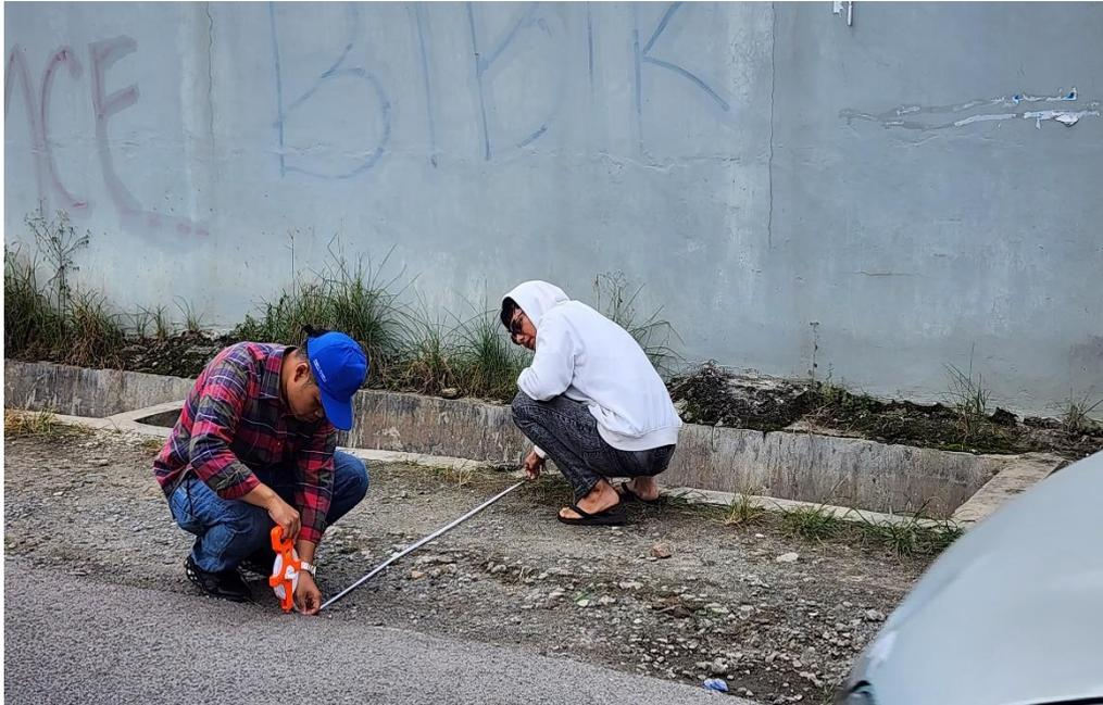
Gambar L. 2 : Pengukuran bahu jalan
