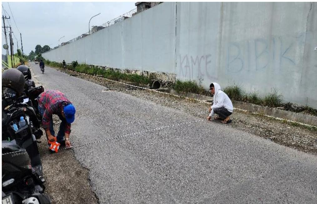
Gambar L. 1 : Pengukuran lebar jalan
