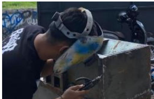
Gambar 4.11 Pengelasan dinding hopper
