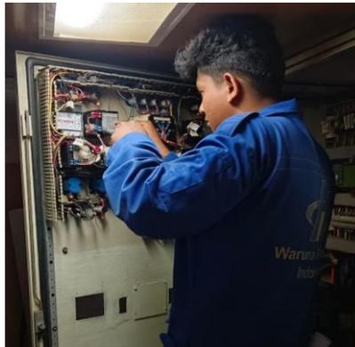
Gambar 4.5 Proses Pelepasan Alat Ukur dari Panel oleh Teknisi
