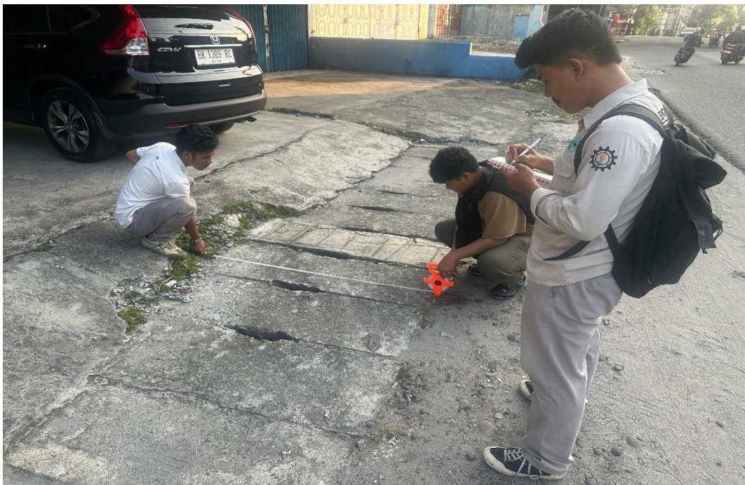
Gambar L 4 : Pengukuran lebar drainase
