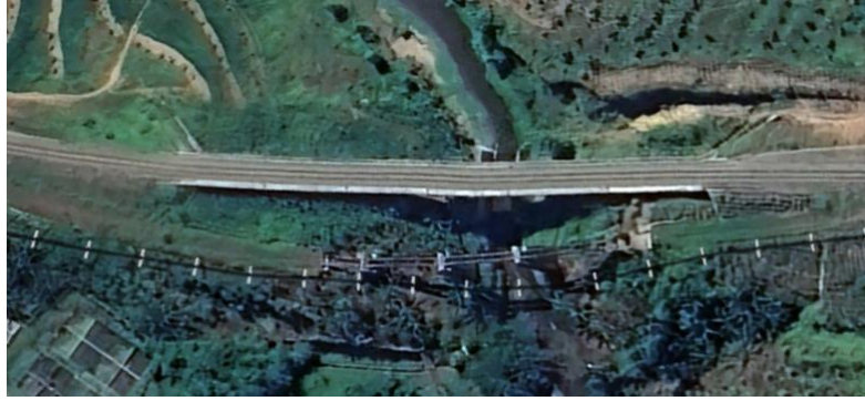
Gambar 3.2: Lokasi jembatan eksisting.
