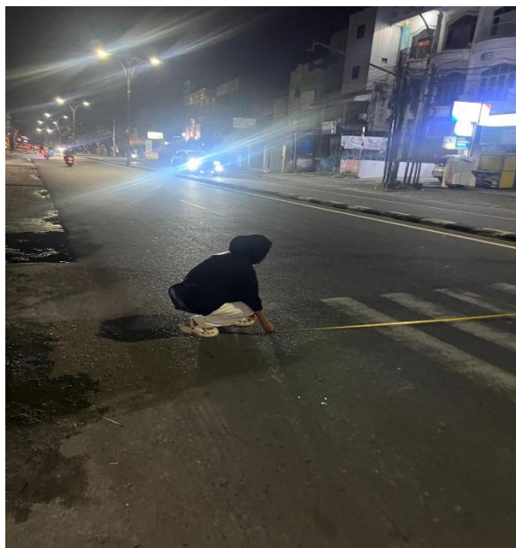
Lampiran Gambar 5: pengukuran lebar jalan KL.Yos Sudarso
