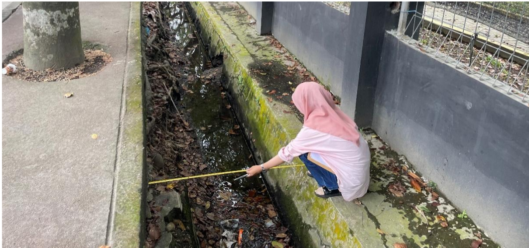
Gambar L 1 : Pengukuran lebar drainase
