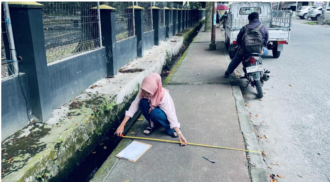
Gambar L 2 : Pengukuran lebar trotoar
