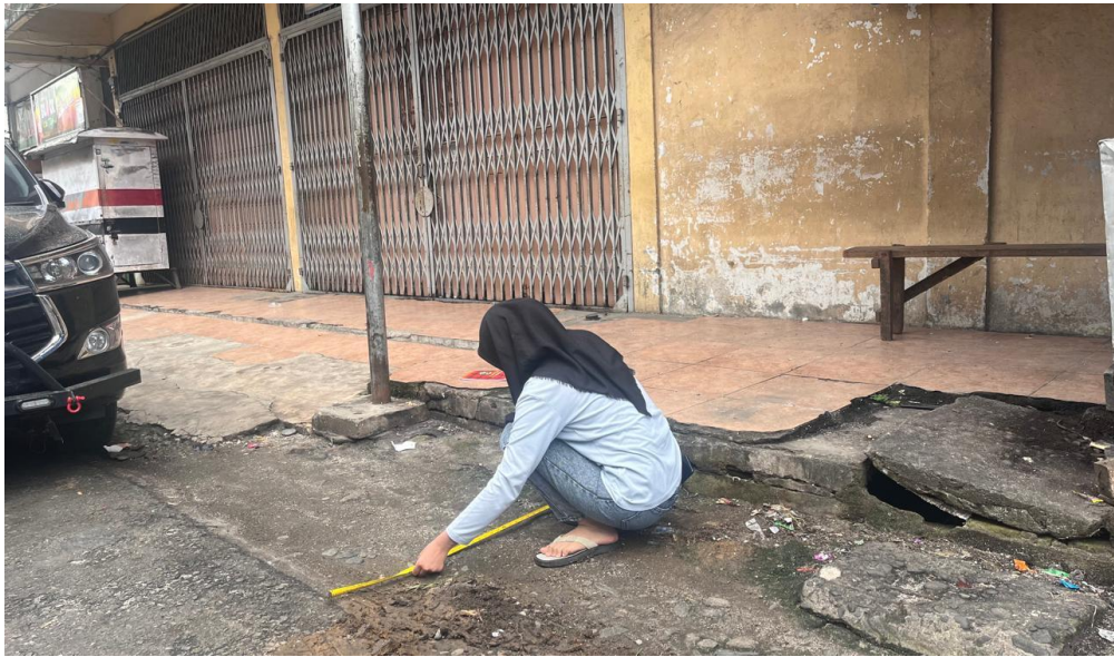
Gambar L 1 : Pengukuran bahu jalan
