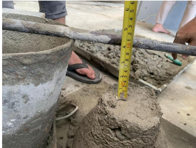
Gambar L-7 Pengecekan Nilai Slump
