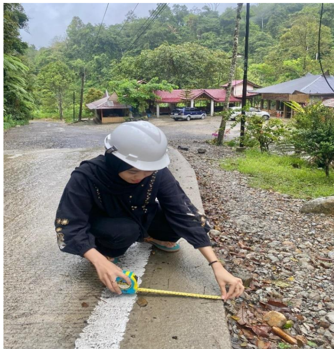
Gambar L6 : Mengukur Bahu Jalan
