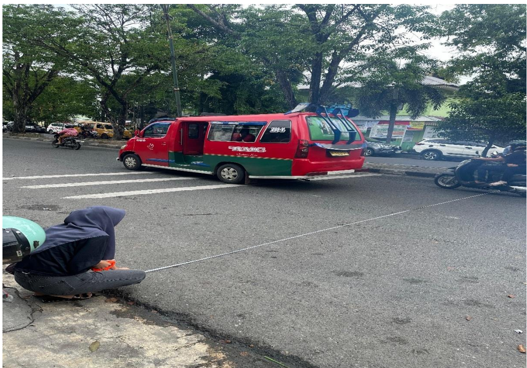
Gambar L 2 : Pengukuran Lebar Jalan
