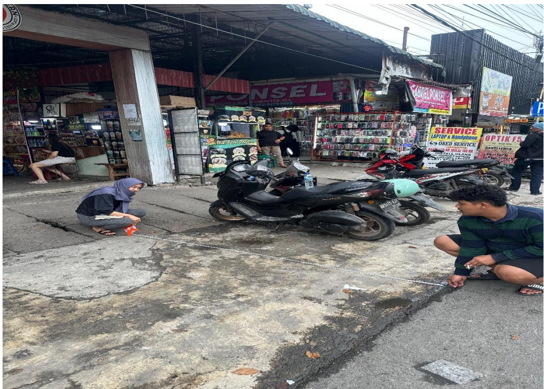
Gambar L 4 : Pengukuran Bahu Jalan
