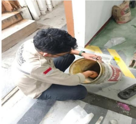
Gambar 3. 41 Mencampurkan seluruh bahan bahan untuk pembuatan mortar
