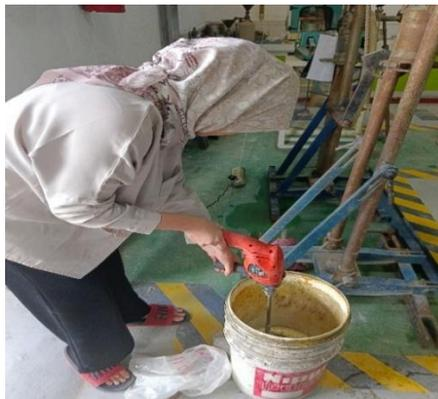
Gambar 3. 42 Mengaduk adonan untuk pembuatan mortar
