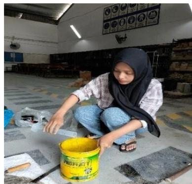
Gambar 3.97: Memasukkan air kedalam adonan secara merata.
