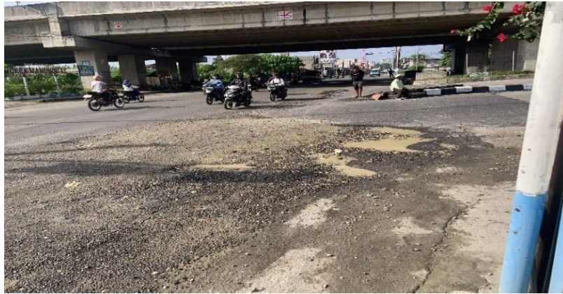
Gambar 3. 9: Pelepasan butir ( Hasil Survey dilapangan)
