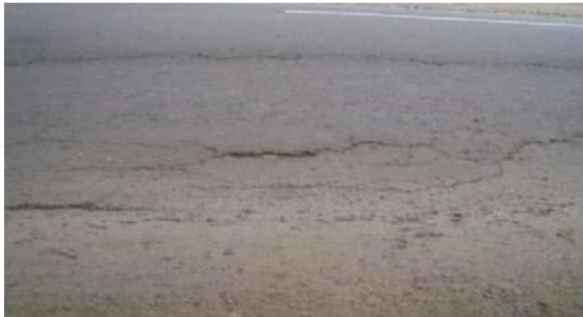
: Gambar 2. 6: Jembul dan lekukan (Zuhdi et al., 2024)
