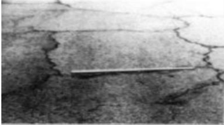
Gambar 2. 5: Retak blok (Zuhdi et al., 2024)
