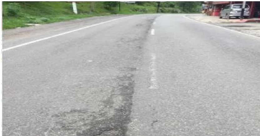
Gambar 2. 12: Retak memanjang/melintang (Zuhdi et al., 2024)
