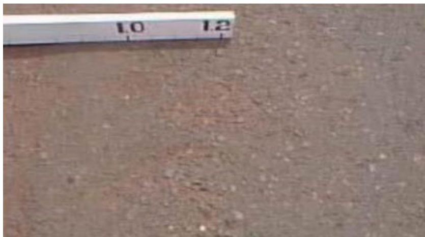
Gambar 2. 14: Pengausan agregat (Zuhdi et al., 2024)
