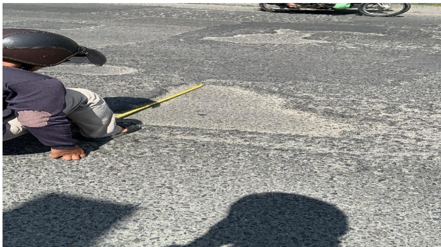
Gambar L.3 : Foto Pengambilan Data Kerusakan
