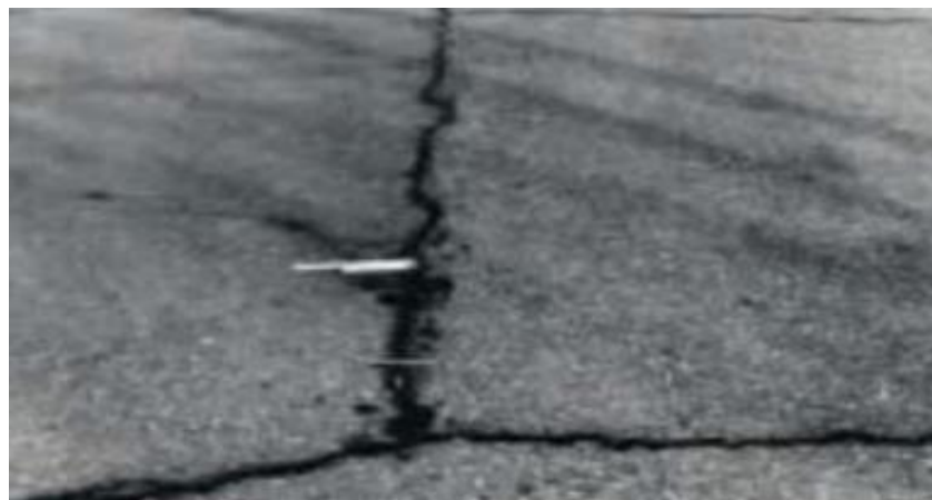
Gambar 2. 10: Retak refleksi sambungan (Zuhdi et al., 2024)
