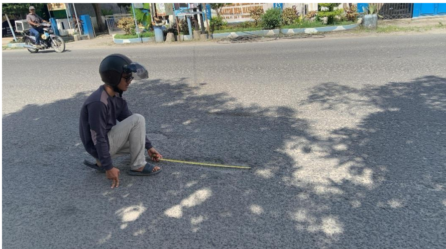
Gambar L.6: Foto Pengambilan Data Kerusakan
