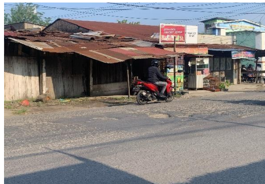
Gambar 3. 3: Foto survei awal lokasi
