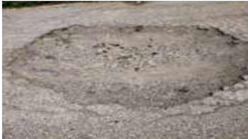
Gambar 2. 15: Lubang (Zuhdi et al., 2024)
