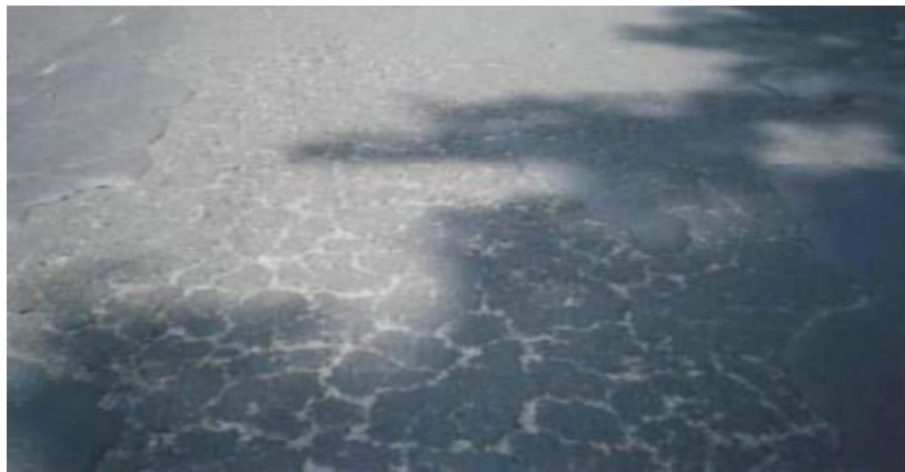
Gambar 2. 21: Pelepasan:butir (Zuhdi et al., 2024)
