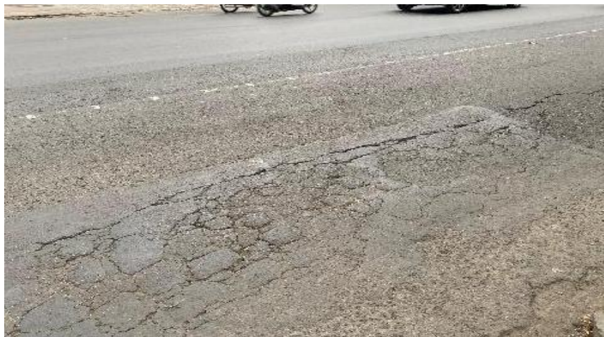
Gambar 2. 3: Retak kulit buaya (Zuhdi et al., 2024)
