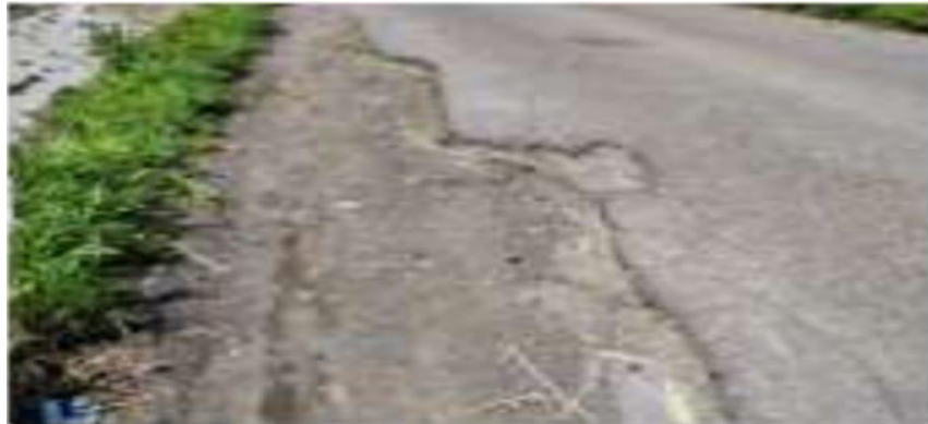
Gambar 2. 9: Retak tepi (Zuhdi et al., 2024)
