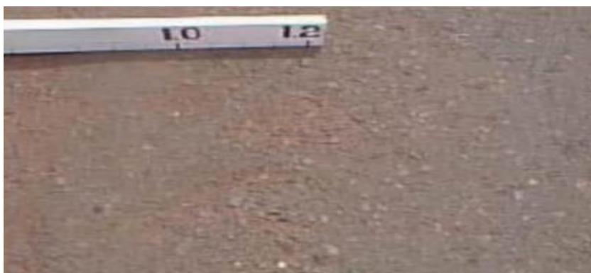
Gambar 2.15: Pengausan agregat (Lestari, 2020)
