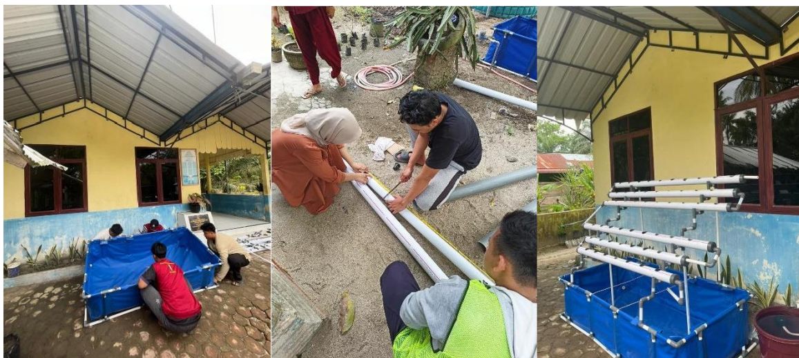
Gambar 4. Pemasangan kolam terpal (a) Pemotongan Pipa aquaponik (b) kolam terpal didiamkan selama 3 hari (c)
