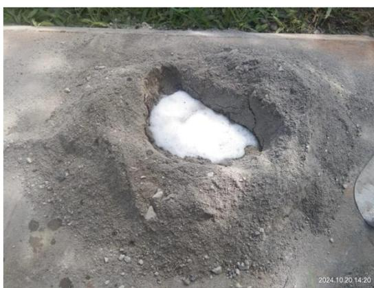
Gambar 4.1. Proses Pencampuran Bahan Komposit Dengan Semen
