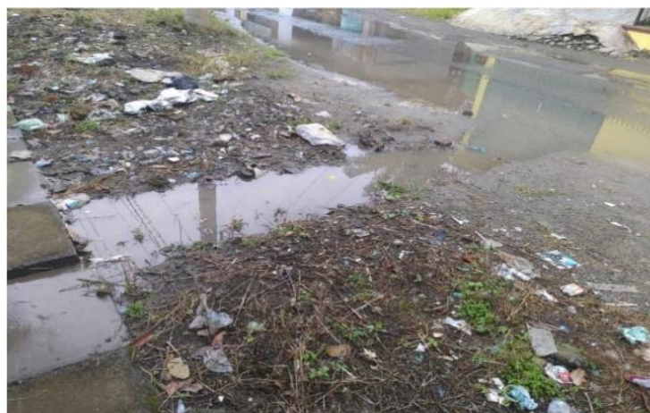
Gambar 4. 16 : Saluran street inlet buatan yang tersumbat
