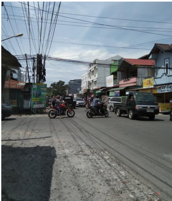
Gambar L.2: Jalan utama, jalan tuasan arah jalan krakatau.
