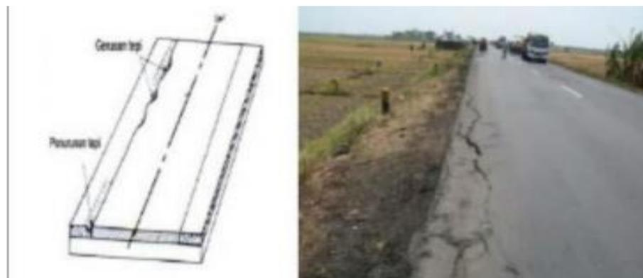
Gambar 2.11 Retak Samping Jalan (Lestari, 2020).
