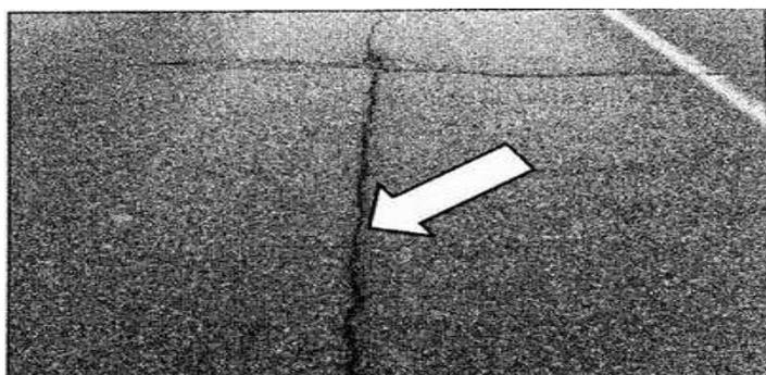
Gambar 3.5 Retak Vertikal/Memanjang.
