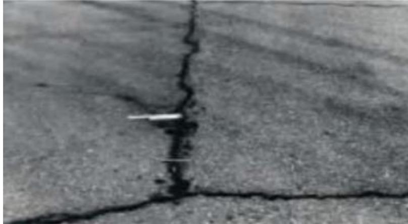
Gambar 2.12 Retak Sambung (Lestari, 2020).
