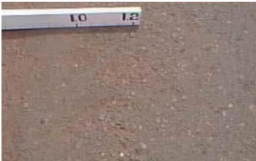
Gambar 2.16 Pengausan Agregat (Lestari, 2020).
