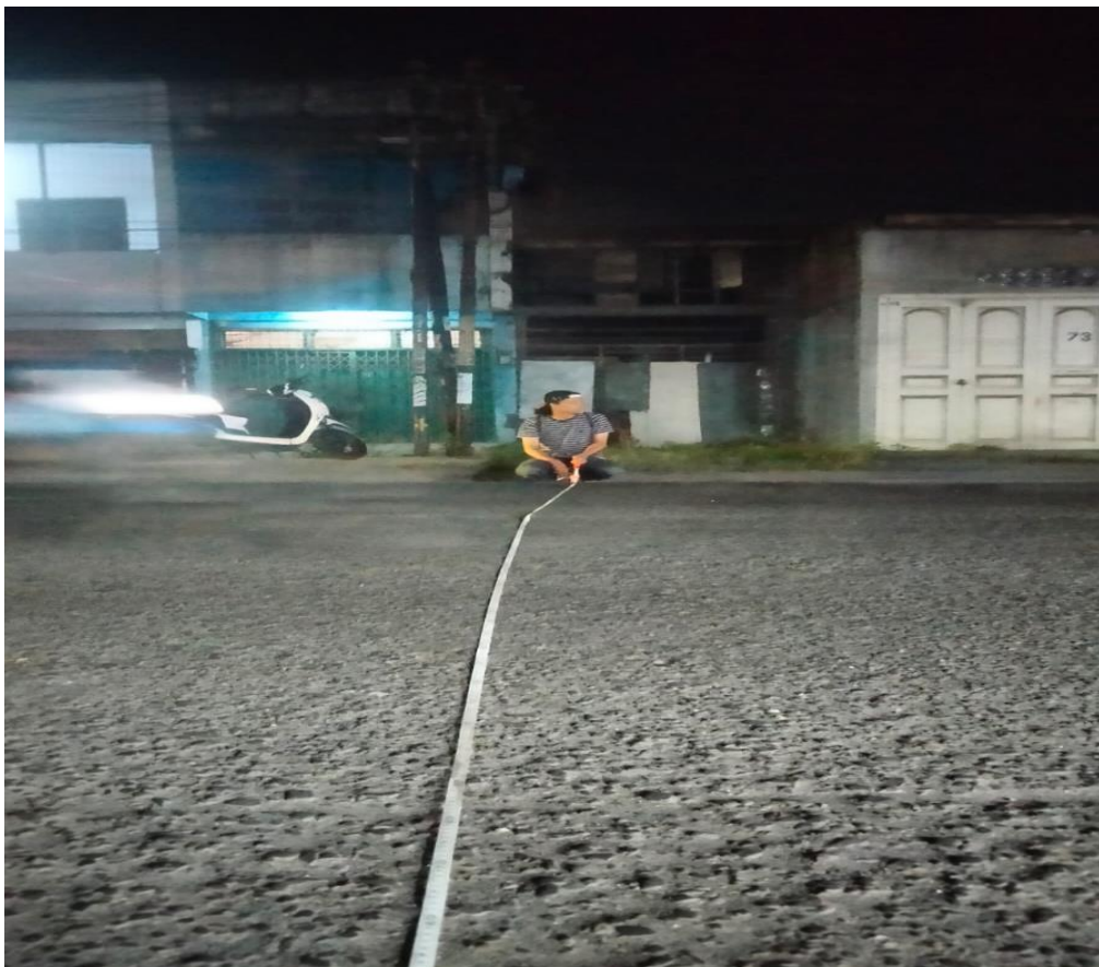
Gambar L. 8 Pengukuran lebar jalan
