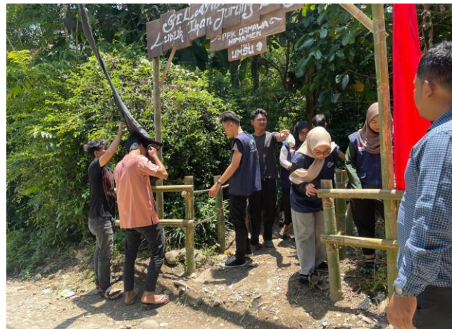
Gambar 4.2 Perbaikan jalan dan pemasangan plang
