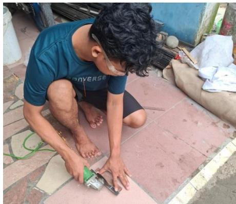
Gambar 4.6 Proses Pemotongan Plat Besi
