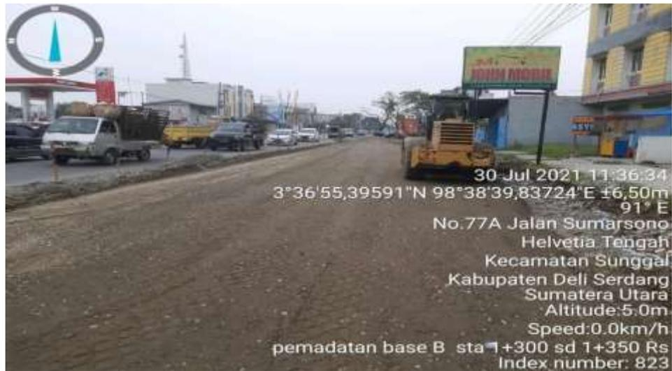
Gambar L.1: Pemadatan agregat kelas B
