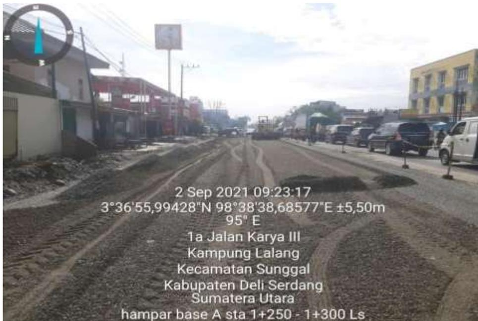
Gambar L.2: Pemadatan agregat kelas A
